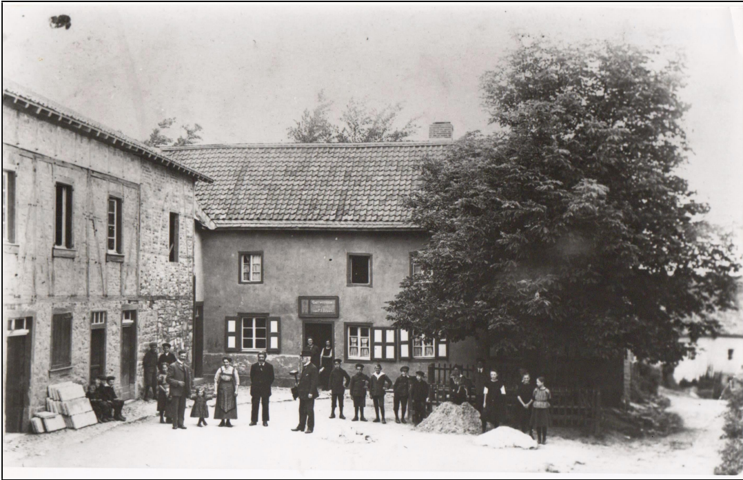
Abbildung 3 – Gaststätte Zur Traube, 1926 Vergrößerung des Saales; vor Umbau der Gaststätte
